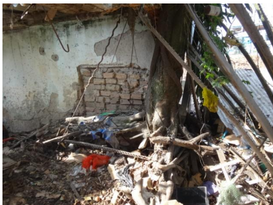
Fechamento da janela no quarto de dormir que acessava a varanda e terreiro, além do estacionamento.
