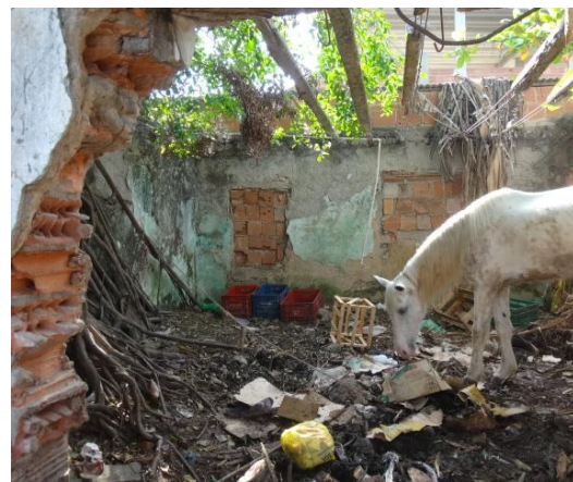
Fechamento da janela e porta do quarto de dormir que acessavam a varanda.
