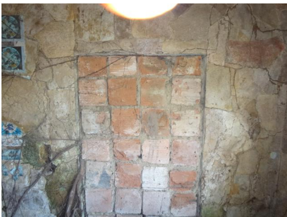
Fechamento do acesso do corredor ao quarto de dormir.
