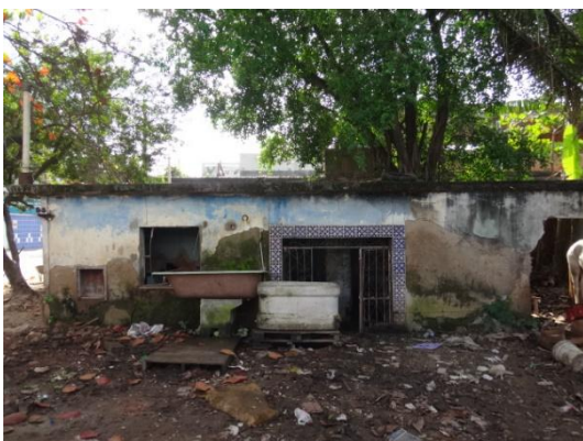
Frente da residência: sua porta de entrada e cerâmica que ladrilhava a mesma.
