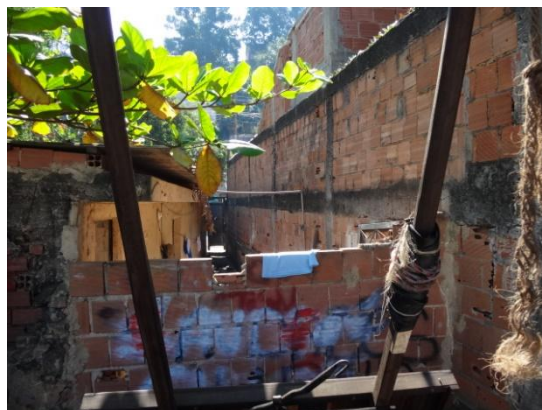
Fechamento da área da varanda. Além desta ação, a cobertura foi subtraída.
