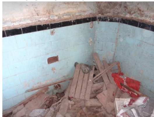
Cerâmica azul utilizada no acabamento da parede do banheiro.
