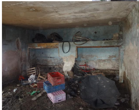
Os nichos que compunham a cozinha.
