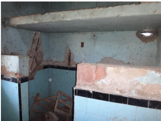
Entrada do Banheiro da residência.
