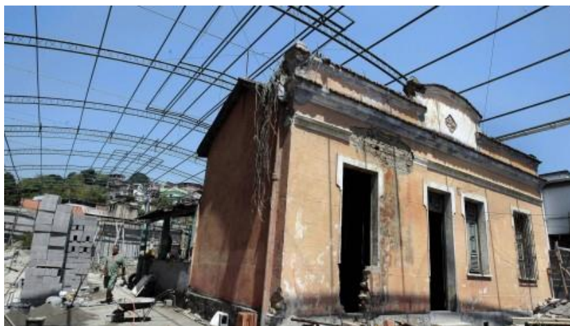
Figura 01 – Derrubada do edifício que abrigou a fundação da Umbanda, em Neves, São Gonçalo. Fonte: Portal Extra Online. Disponível em: < https://extra.globo.com/noticias/religiao-e-fe/casa-onde-foi-fundada-umbanda-em-sao-goncalo-sera-demolida-esta-semana-2682118.html >. Acesso em: 01.jun.2020.
